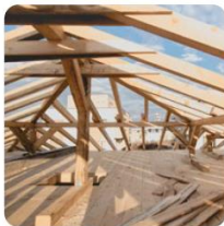
3. Structure, maçonnerie, gros œuvre, charpente
