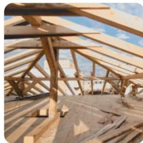
3. Structure, maçonnerie, gros œuvre, charpente
